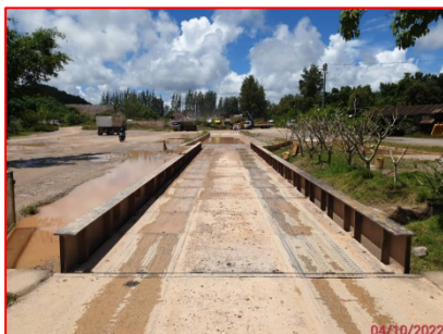
(10) ระบบให้น้ำล้างล้อรถบรรทุกอัตโนมัติ
